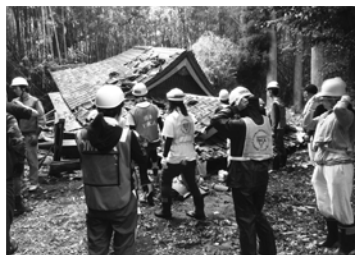
熊本地震 瓦礫撤去ボランティア支援
